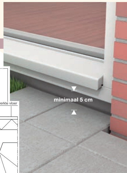
Afstand onderkant kozijn - bestrating
